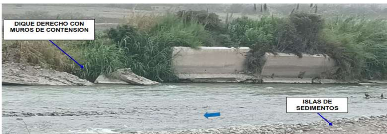
FIGURA N°01: RIO CHANCAAY HUARAL, MARGEN DERECHA AFECTADA POR LA DEGRADACION AVANZADA DE SU DIQUE DE PROTECCION Y EL COLAPSO ESTRUCTURAL DE LOS MUROS DE CONTENCION, GENERANDO INESTABILIDAD GEOMORFOLOGICA Y RIESGOS DE INUNDACION EN EL SECTOR.
