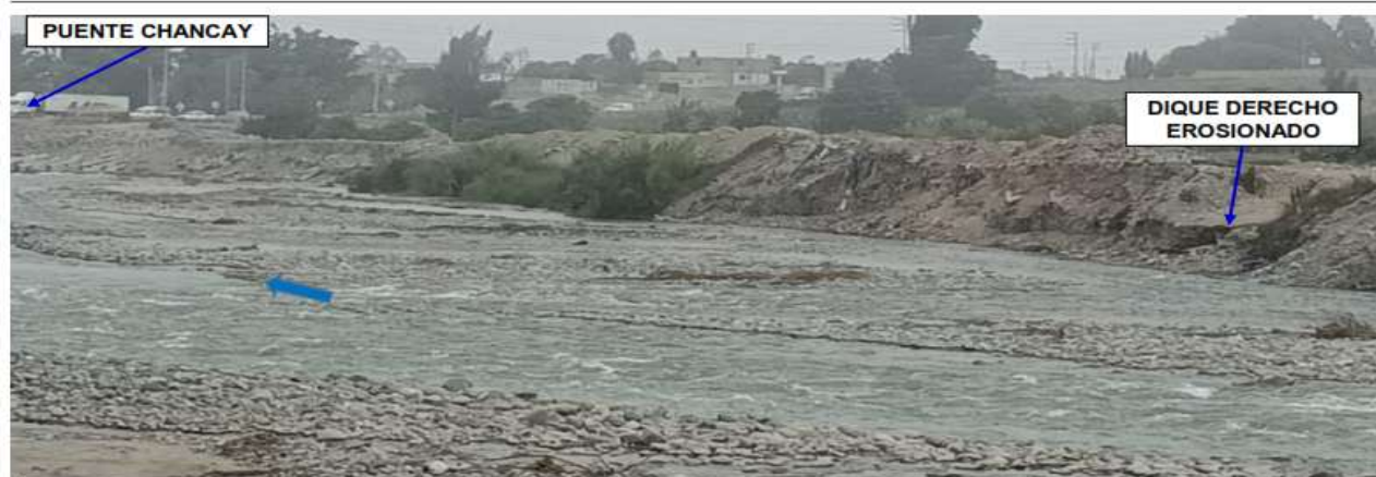
FIGURA N°02: RIO CHANCAAY HUARAL, CON EL DIQUE DERECHO CONFORMADO DE MATERIAL PROPIO MUY EROSIONADO Y EL CAUCE DEL RIO COLMATADO DE FLUJO DE DETRITOS CON RIESGOS DE INUNDACION EN EL SECTOR.
